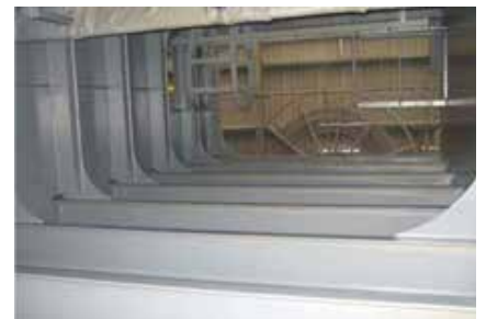
Aplicação em estágios de blocos
